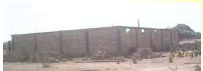
La chapelle de Béréba en construction
